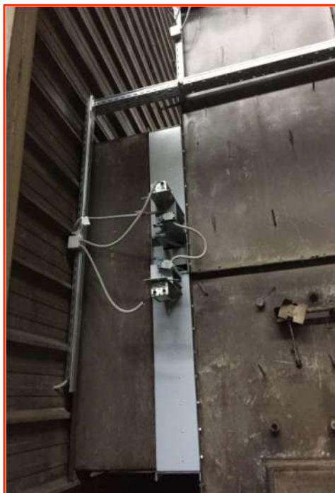
Новый клапан на существующем корпусе кондиционера
