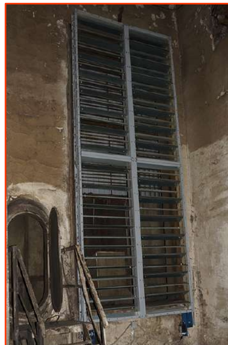
Новый клапан в строительной конструкции
