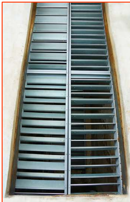
Новый клапан в строительной конструкции
