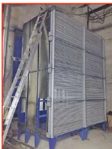
Новые калориферы в процессе установки
